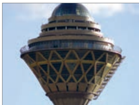
شکل ۱- سازه فلزی برج میلاد
